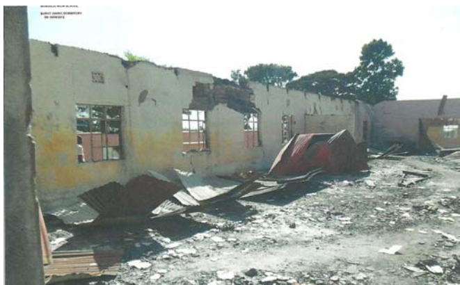
ようやく鎮火したマランダ学校の様子。
